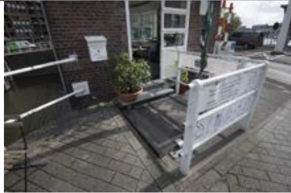
Lage Erfbrug, Rotterdam: mobiele traptreden naar voordeur op vloerluik brugkelder
