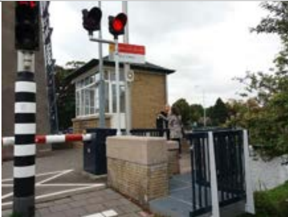
Oude Tolbrug, Voorburg: vlonder van roosters buiten slagbomen om
