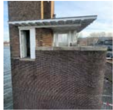
Landhoofd Oude Willemsbrug O
